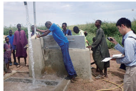
初の海外出張でセネガルの地方給水案件における瑕疵検査業務の様子
